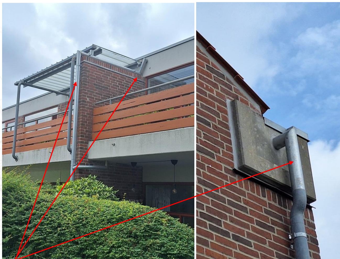
Nye udførte korrekte udvendige synlige nedløb, ført til eksisterende tagbrønde i terræn.
