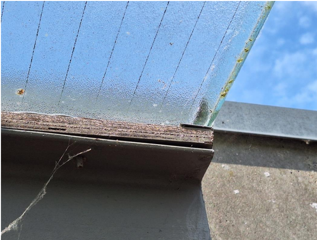
Her ses igen et eksempel på blottet ubeskyttet krydsfiner.
