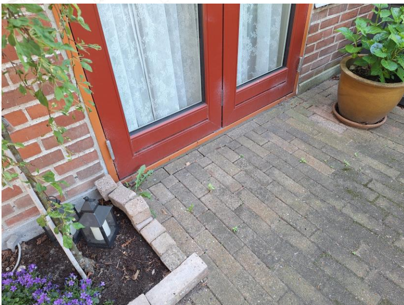
Her ses eksempler på fejlmønteret døre, som er monteret for tæt på sokkel og terræn.
