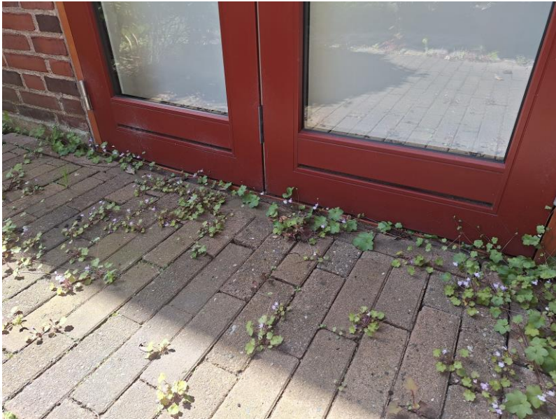
Her ses eksempler på fejlmønteret døre, som er monteret for tæt på sokkel og terræn.
